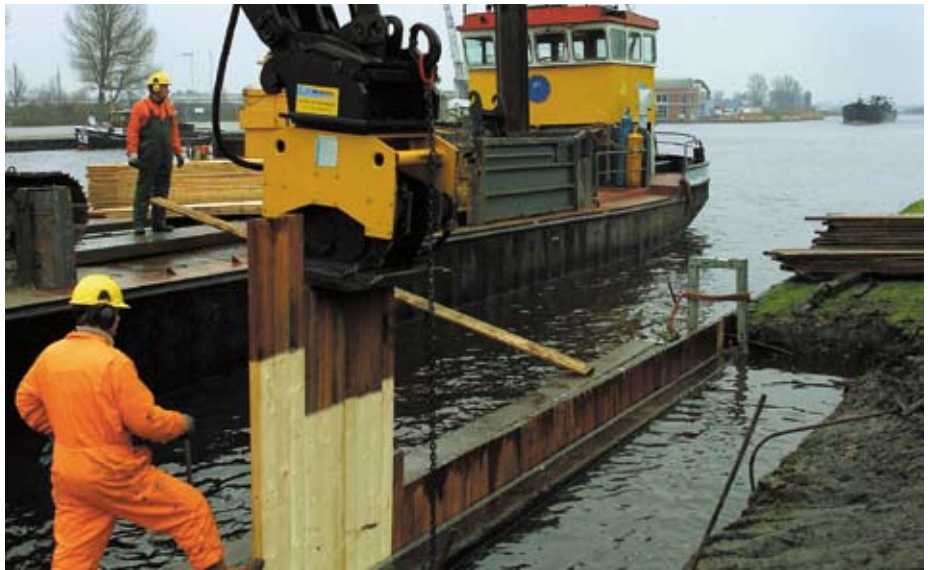
Plaatsing van een H2H-damwand. (Foto Van Swaay)
